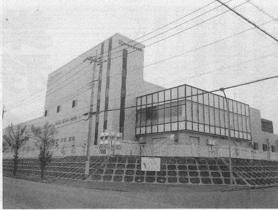
新熱工業がひたちなか市の本社に完成した新工場
